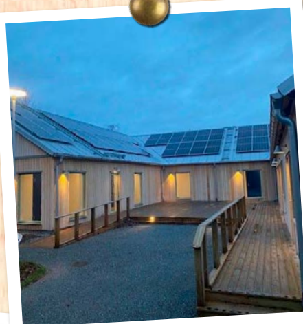
Installerat solceller på det nybyggda LSS-boendet i Tureberg
